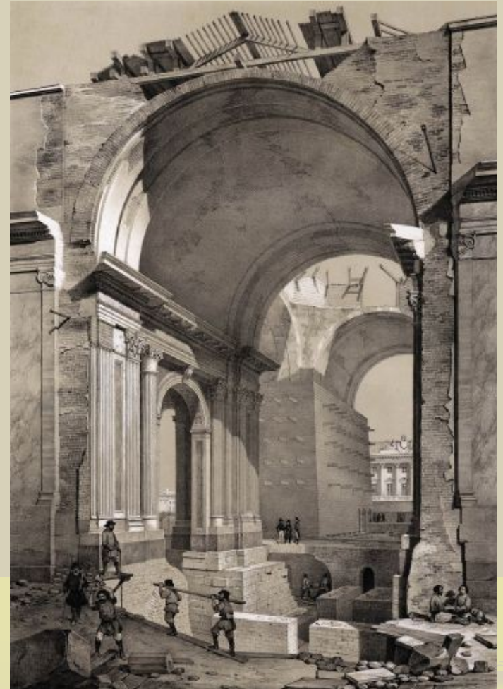
Вид разборки и сохраненных частей предыдущей Исаакиевской церкви
