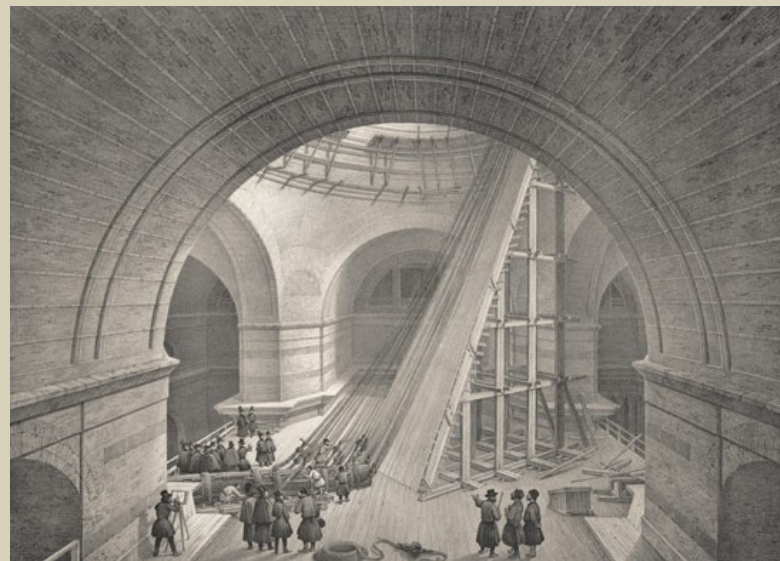
Внутренний вид части церкви и помоста для подъема колонны к барабану купола.
