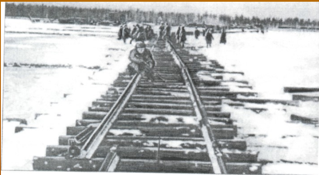
Строительство железной дороги по льду Ладожского озера зимой 1942/43 г.
