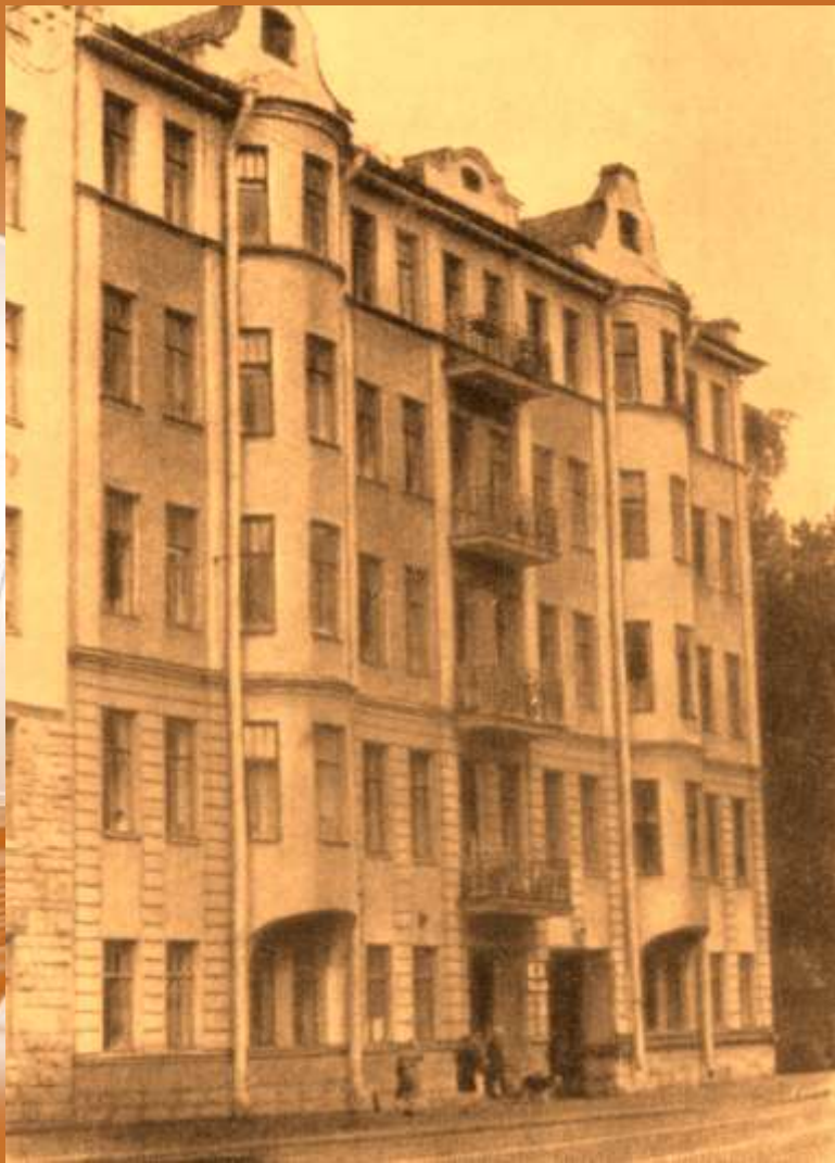
Дом на Тверской улице, где жил А. Н. Лодыгин в 1909 – 1910 гг.
