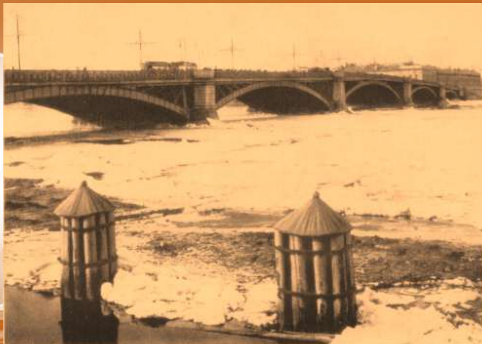
Литейный мост. Подводные лампы накаливания Лодыгина светили при ремонте кессонов
