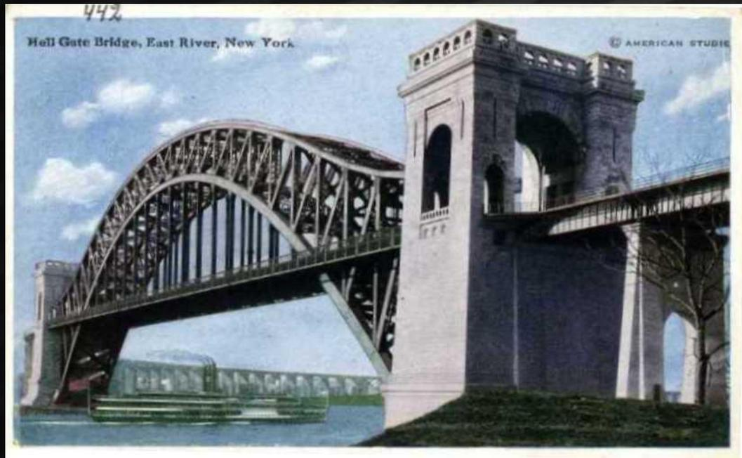
Инженер-мостостроитель Густав Линденталь построил огромный по тем временам арочный железнодорожный мост пролетом 298 м через одноименный канал, являющийся ответвлением пролива Ист-Ривер. Сложные геологические условия потребовали при его строительстве большого объема земляных работ.
