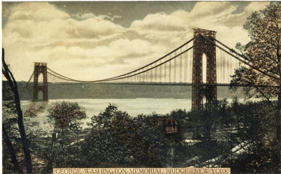
Мост Джорджа Вашингтона – один из лучших висячих мостов по своей архитектуре. Сквозная металлическая конструкция его пилонов хорошо гармонирует с ландшафтом берегов, покрытых растительностью. Общая длина моста 1450 метров, длина подвесной части моста 1100 метров, высота двух несущих опор 184 метра, ширина моста 36 метров.
