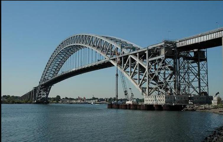
Это первый мост, в котором использовалась марганцевая сталь для основных ребер и заклепок. Изящная арка напоминает параболу и состоит из сорока линейных сегментов.
