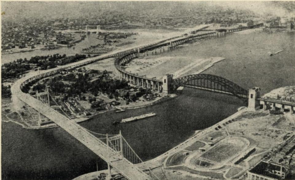
171. Комплекс дорог Трайборо, 1929—1936 гг. Висячий мост Хельгет, пролеты:  $204,5 + 420,5 + 204,5$  м, ширина полотна 32,8 м, высота порталов из кремнистой стали 96 м, 8 полос движения. Вдали узел развязки движения и подъемный мост. На втором плане двухшарнирный арочный мост Хельгет под ж. д. Инж. Линденталь и арх Горабостен, 1912—1913 гг. Пролет 297,8 м, стрелка 1:4, ширина 28,4 м
