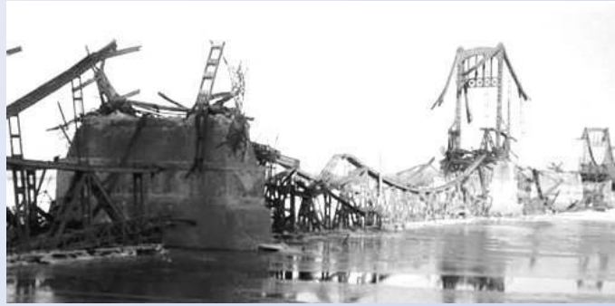
Разрушенный мост им. Е. Бош
