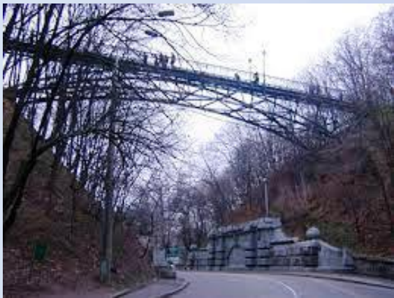
Малый мост Патона после реставрации
