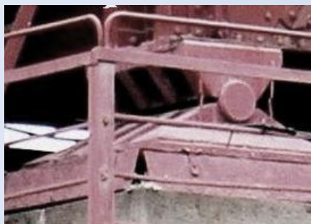
Шарнирная опора фермы
