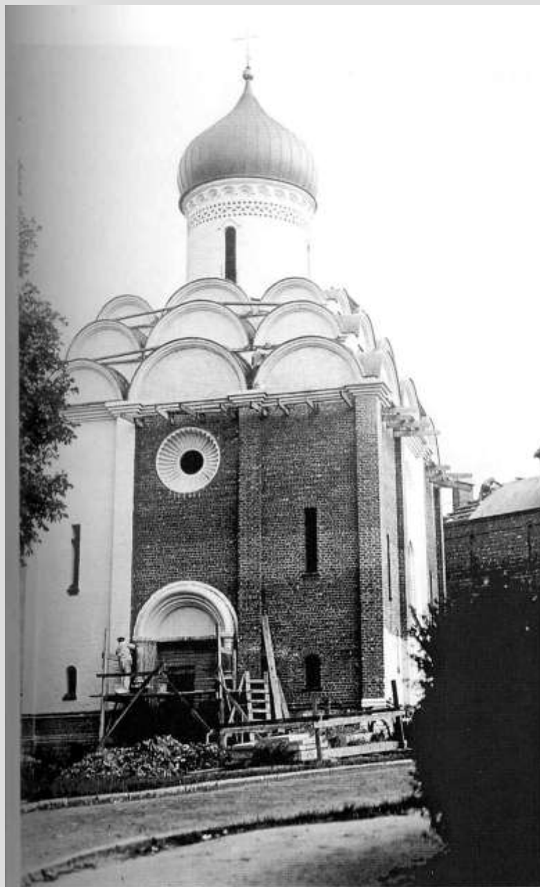
Окончание фасадных работ осенью 1938 г.
