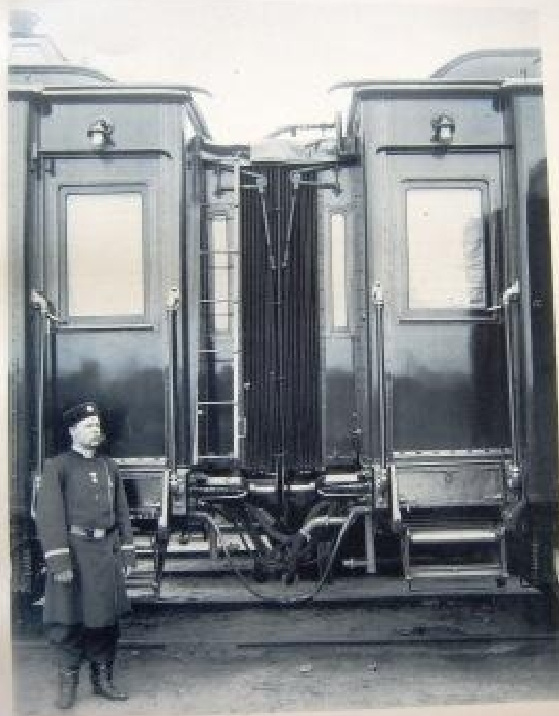
Соединение вагонов между собой.
