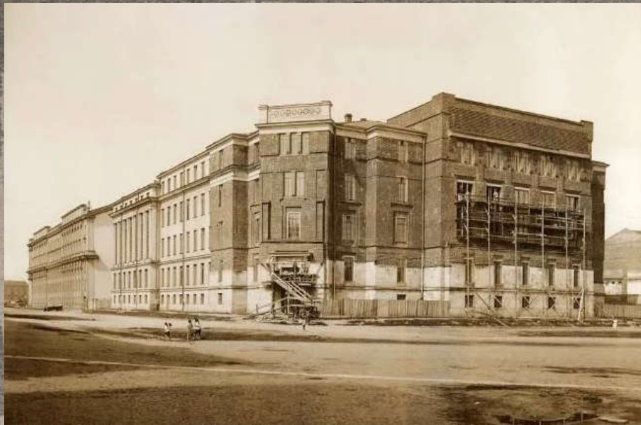
Строящееся здание библиотеки Академии наук, 1914 г., г. Санкт-Петербург.
