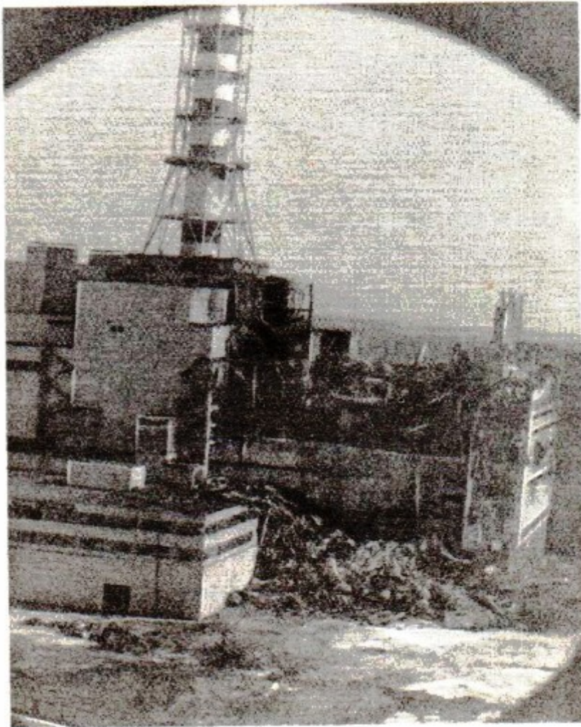
Вид части здания 4-го энергоблока Чернобыльской атомной электростанции, разрушенной в результате взрыва ядерного реактора. (Снимок сделан с борта вертолета 26 апреля 1986 г. Плохое качество фотографии — результат воздействия радиации на фотопленку.)
