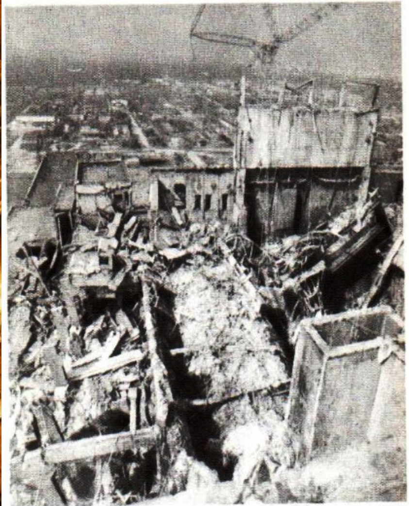
Так выглядел развал 4-го энергоблока Чернобыльской АЭС (снимок сделан в начальный период работ по сооружению «Укрытия»).
