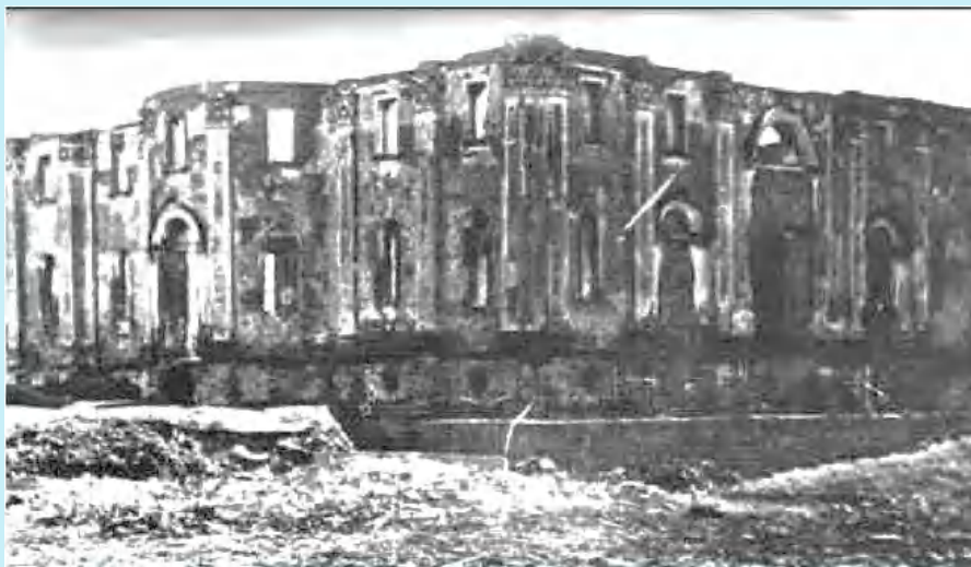
Руины церкви перед сносом. Начало 60-х
