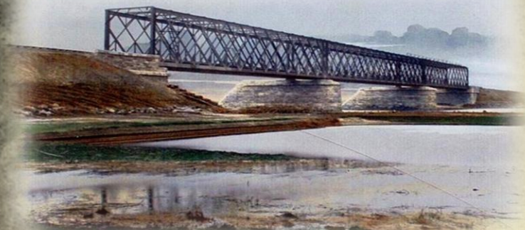
Мост через реку Воронеж
