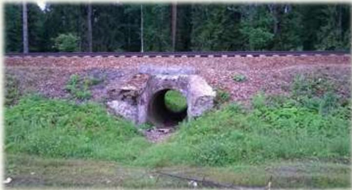
Среди разнообразных видов искусственных сооружений на железных дорогах самыми массовыми являются водопропускные трубы. Важнейшей особенностью труб является непрерывность земляного полотна и рельсового пути над трубами, что обеспечивает наилучшие условия для пропуска временной нагрузки.
