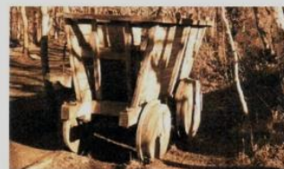
Шахтная вагонетка английской деревянной рельсовой дороги начала XVIII в.
