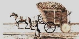
Вагон с углем, перемещающийся конной тягой по Уоллатонской вагонной дороге, начало XVII в., Англия
