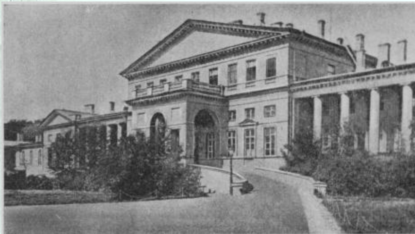
Дворец князя Юсупова на набережной р. Фонтанки, в котором размещался Институт Корпуса инженеров путей сообщения с 1809 по 1822 гг.
