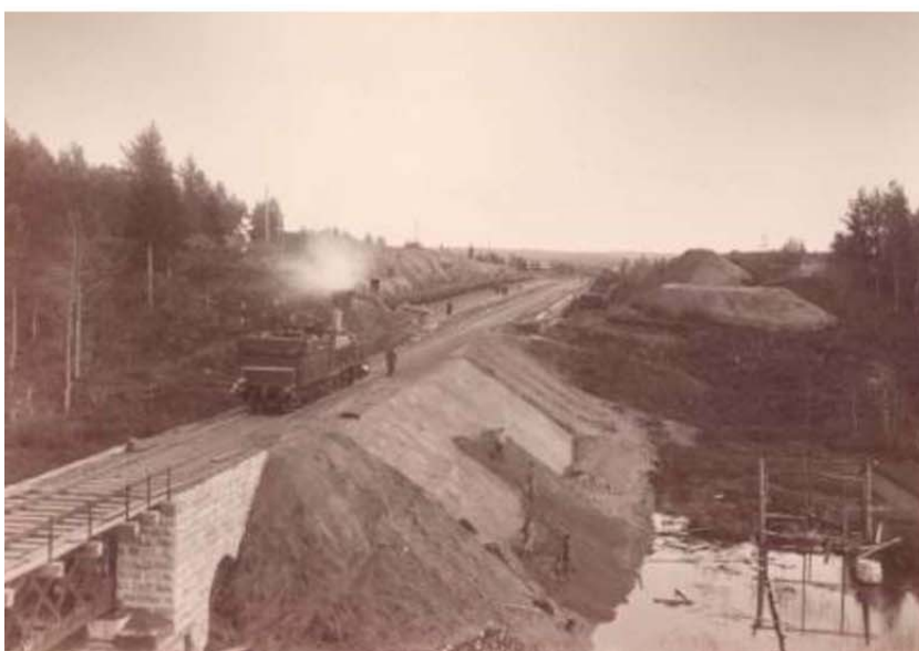
Строительство Костромской линии. Фотографии из фонда Научно-технической библиотеки
