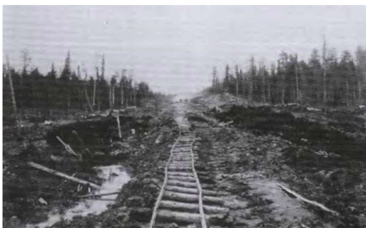
542-я верста. Осадка полотна на болоте при производстве работ
