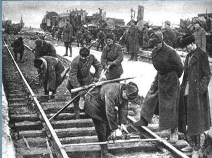
Путейцы, строители, стрелочники, машинисты, инженеры, когда требовалось, работали землекопами, молотобойцами, грузчиками. Не хватало механизмов, материалов, питания, но приказ ГКО был выполнен: 20 разъездов построены точно в установленный срок. Пропускная способность Астраханской линии была увеличена в 2 раза.
