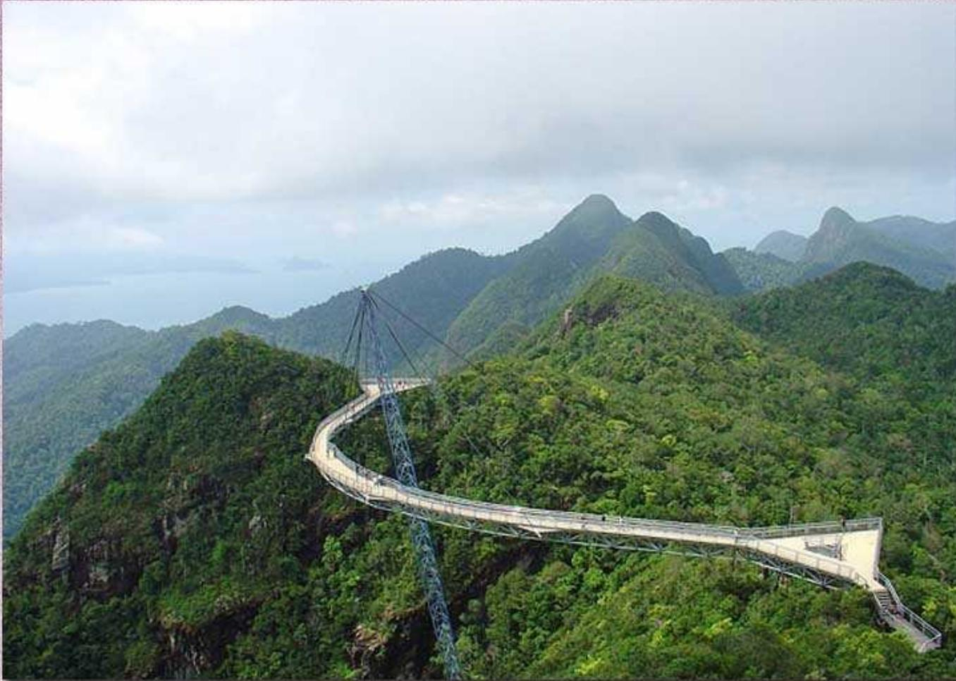
**Длина моста составляет 125 метров. Он закреплен всего на одной колонне и дополнительно держится на тросах, закрепленных на скалах. Мост изогнут, и создается полное ощущение, что он парит над пропастью.**
