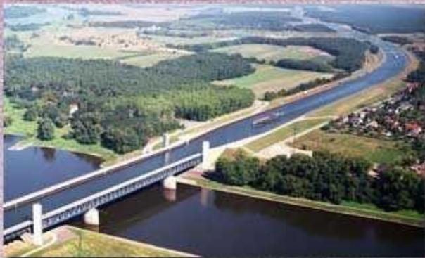
**Магдебургский водный мост — крупнейший в Европе судоходный мост-канал над Эльбой длиной в 918 метров с системой шлюзов со сберегательными бассейнами — грандиозный гидротехнический проект, с помощью которого удалось обеспечить прямую связь между Ганновером, Магдебургом и Берлином. Соединяет два важных канала: Канал Эльба-Хафель и Среднегерманский канал, через который осуществляется сообщение с индустриальным районом — долиной Рура. Мост находится в 10 км к северу от центра Магдебурга.**
