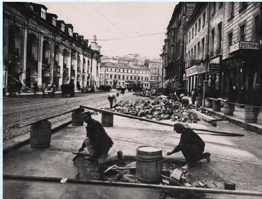
Садовая улица. Ремонт мостовой после наводнения
